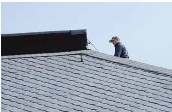
◀ „Skręcające” płytki na narożu
