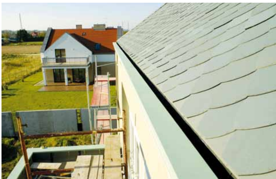
▲ Na dachu nie ma tradycyjnych rynien – jest zagłębione koryto na okapie
