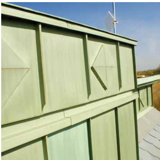
▲ Obróbka muru kryjącego kominy
