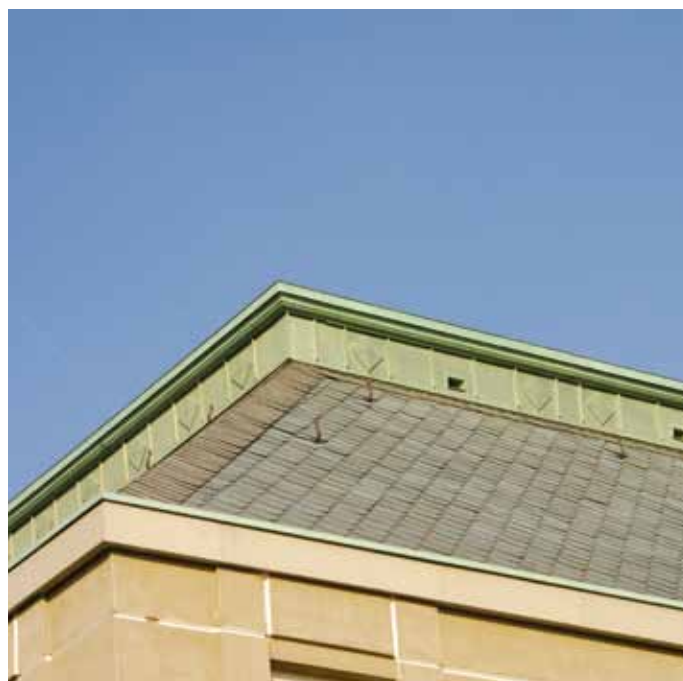
▲ Fragment gotowego dachu
