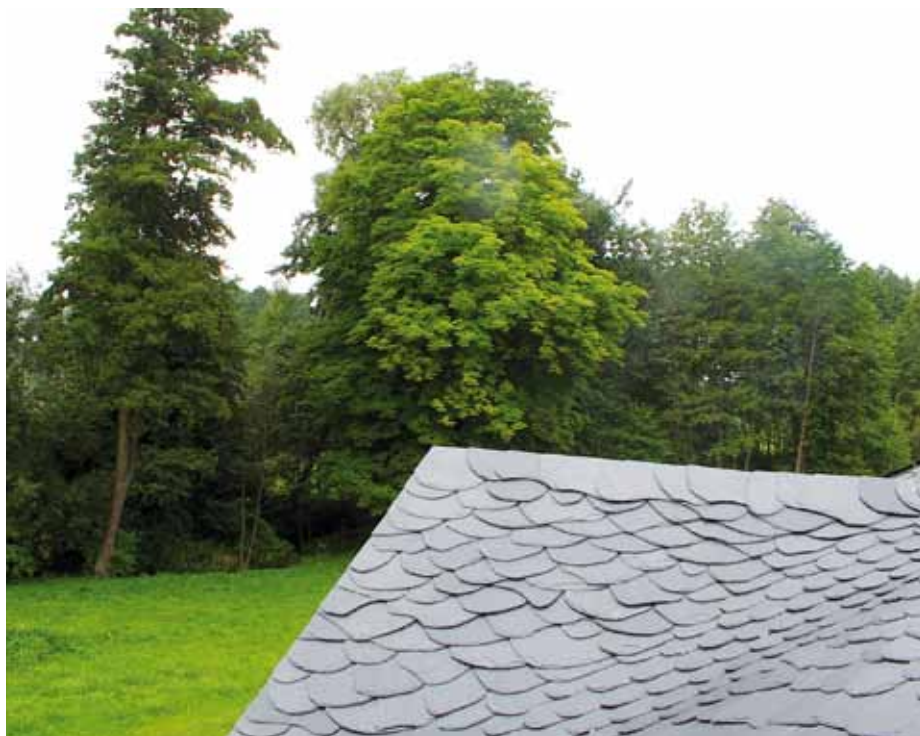
▲ Fot. 3. Pływająca kalenica – pracochtonna, ale niezwykle efektowna
