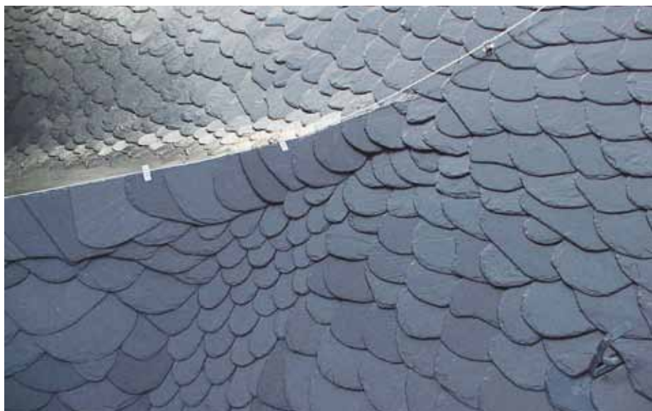
▲ Fot. 7. Wododział na tępkowym dachu
