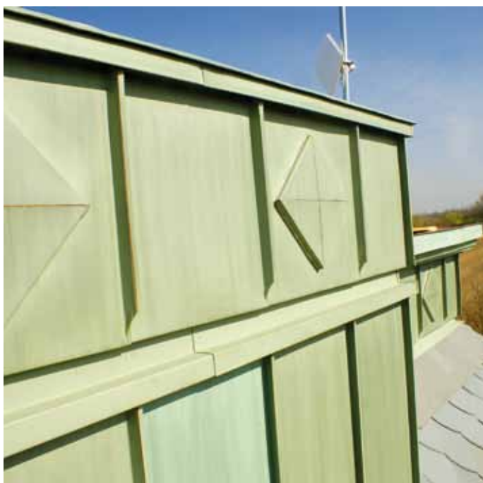
▲ Obróbka muru kryjącego kominy
